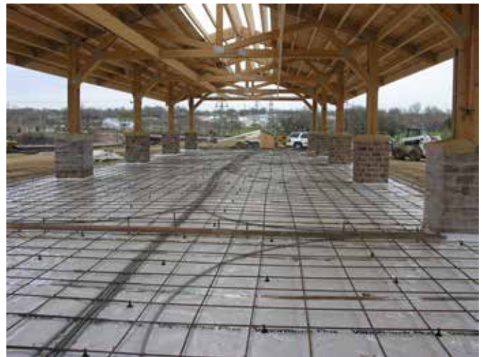
Under-Slab Vapor/Gas Retarder
